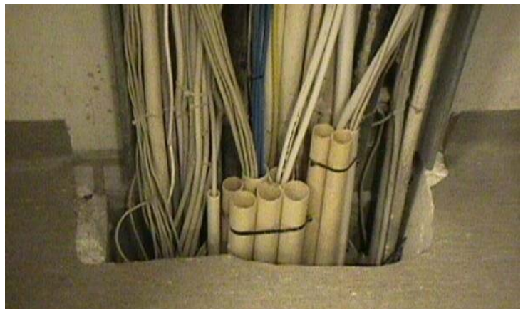
Kuva 5: Tavalliset muoviputket eivät täytä varauksille asetettuja vaatimuksia.
