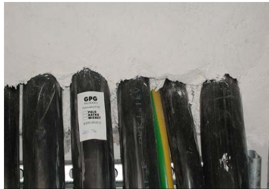
Kuva 4: Tyyppihyväksytty palokatko on merkittävä tyyppihyväksyntää osoittavalla tarralla tai kilvellä. Tarrasta tai kilvestä tulee käydä ilmi STF –merkki, hyväksynnän numero, käytetty järjestelmä, paloluokka, asentaja ja asennuksen ajankohta.
