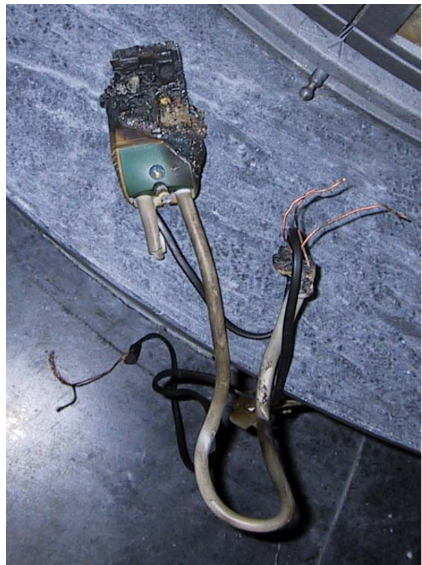
Kuva 6: Halogeenivalaisimen muuntajan virheellisessä asennuksessa voi piillä sähköpalariski. Kuva Paavo Hakala
