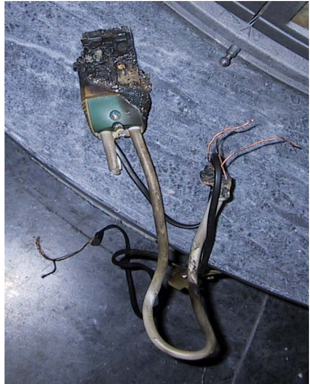
Kuva 5: Halogeenivalaisimen muuntajan virheellisessä asennuksessa voi piillä sähköpalariski.
