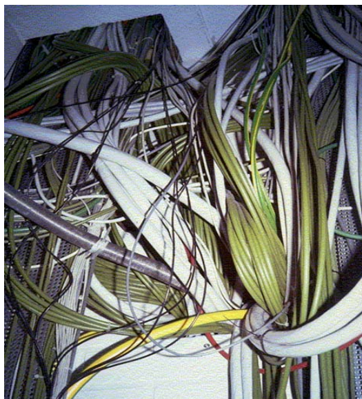
Bild 3: Kabelmängderna bör tas i beaktande redan vid planering av brandtätningarna!
