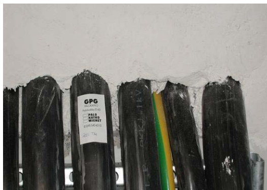
Bild 4: En typgodkänd brandtätning skall märkas med en etikett eller en skylt som utvisar typgodkännandet. Av etiketten eller skylten skall framgå STF-märket, godkännandets nummer, använt system, brandklass, installatör och installationens tidpunkt.
